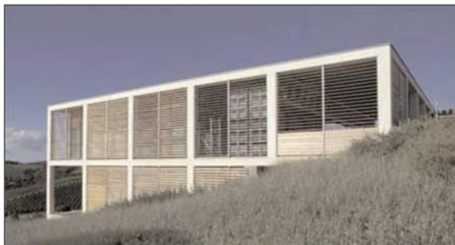
Stabilimento enologico "Collemassari" Loc. Poggi del Sasso – Cinigiano (Grosseto) Edoardo Milesi - Archos engineering consulting
