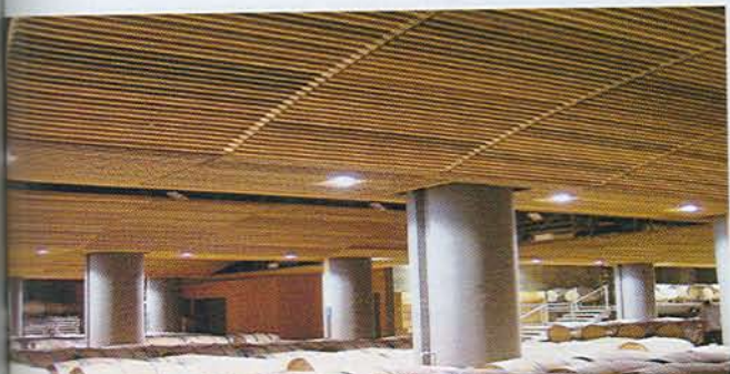
↑ Edoardo Milesi/Archos engineering consulting, stabilimento enologico Collemassari Collemassari oenological plant, Poggi del Sasso (Cinigliano, Grosseto).
