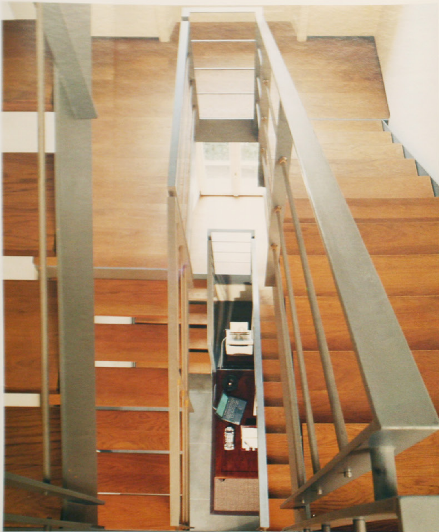
SOPRA , UN'IMMAGINE DALL'ALTO DELLA SCALA IN LEGNO E ACCIAIO. NELLA PAGINA SEGUENTE , IL PICCOLO ED ELEGANTE SOGGIORNO DELLA CASA A CAVENAGO, VICINO BERGAMO. IN QUESTO, COME IN TUTTI GLI ALTRI AMBIENTI DOMESTICI, LE VERNICI SONO PRODOTTE CON COMPONENTI NATURALI, GLI INTONACI SONO A CALCE. LA CASA, INFATTI, SEGUE I DETTAMI DELLA BIOARCHITETTURA.
