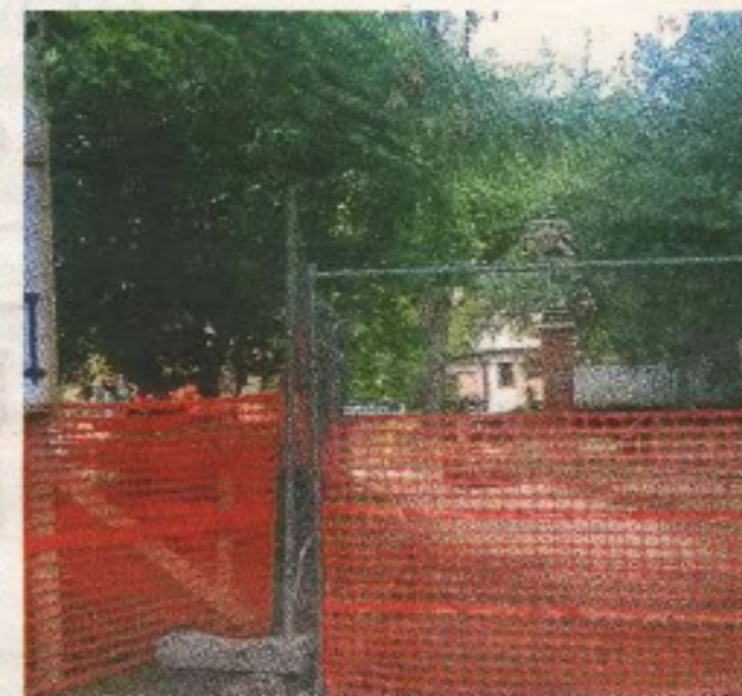
Il cantiere della passeggiata sulle mura medicee di Grosseto
