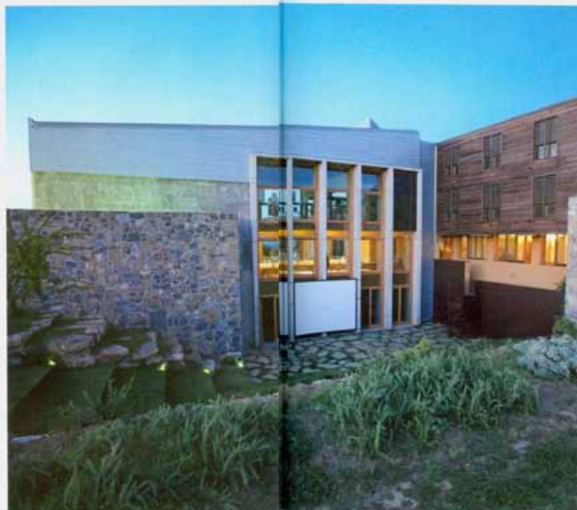
Sopra, Uno scorcio del monastero di Siloe, Poggi del Sasso (Gr), in fase di realizzazione su progetto dell'architetto Edoardo Milesi
