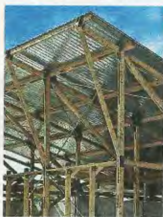
Le opere Case in legno anti terremoto
