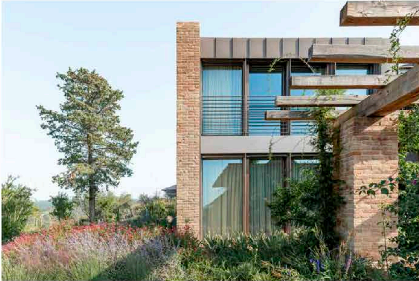
Fronte finestrato di un corpo abitativo.
