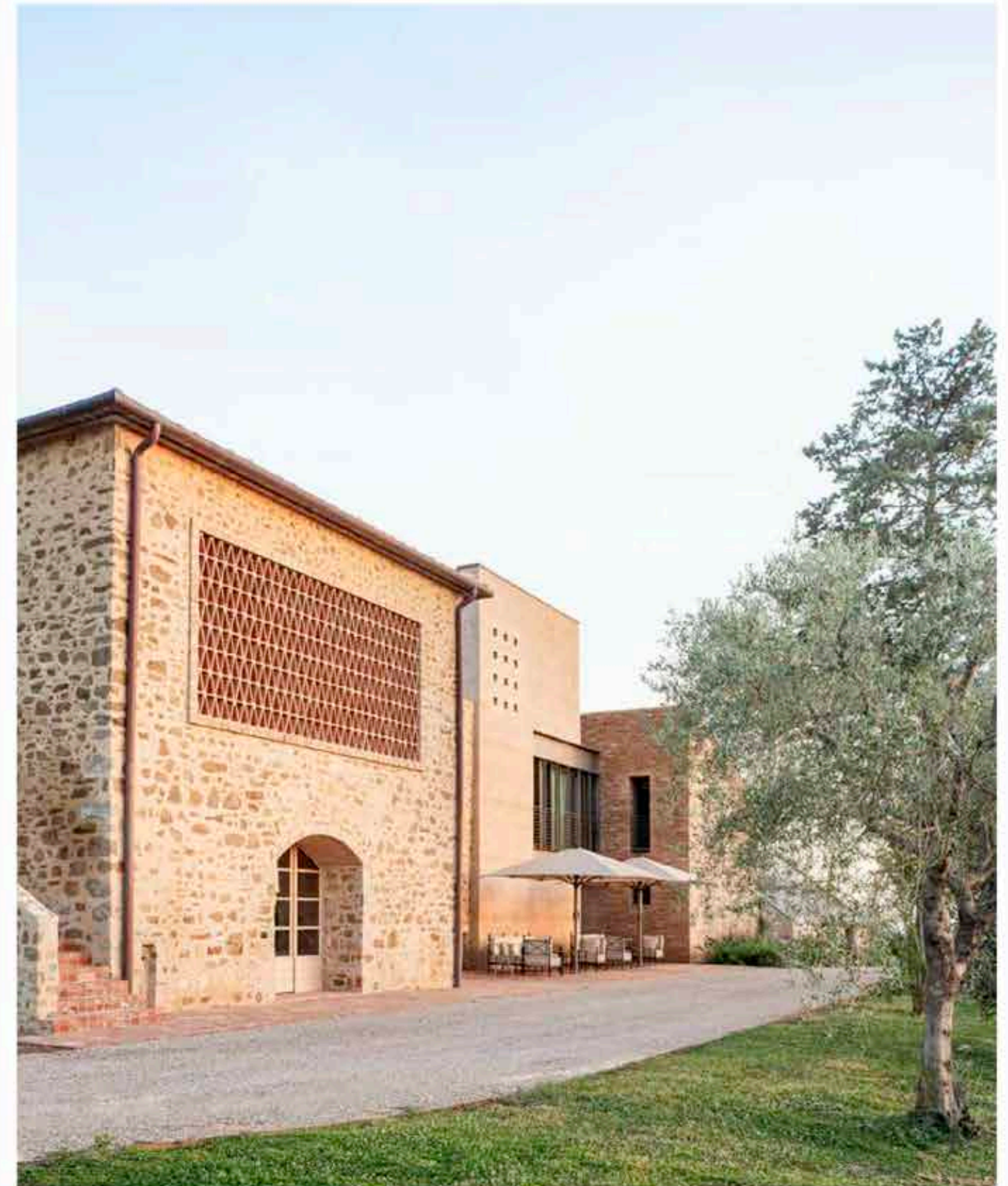
I corpi della parte abitativa.
